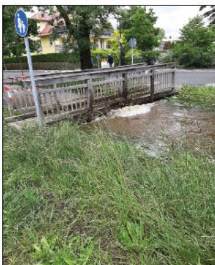
2024 Hochwasser im Juni
