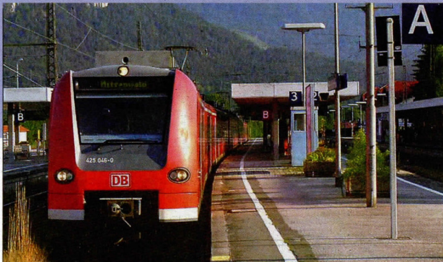
Eine der vielen Strecken, die dringend zweigleisig ausgebaut werden müssen, ist die Bahnstrecke München – Weilheim – Garmisch-Partenkirchen
