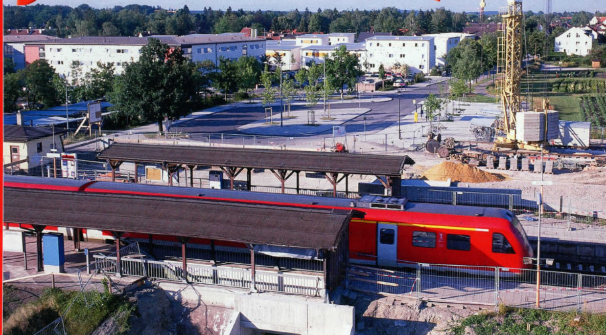
Bauzustand des neuen Bahnhofsvorplatzes im Juli 2003 mit Neubaugebiet
