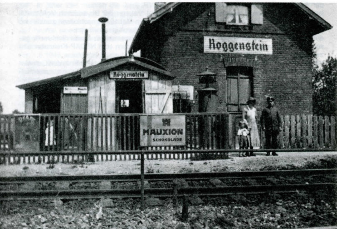
Eichenaus Bahnstation »Roggenstein« (bis 1935)
